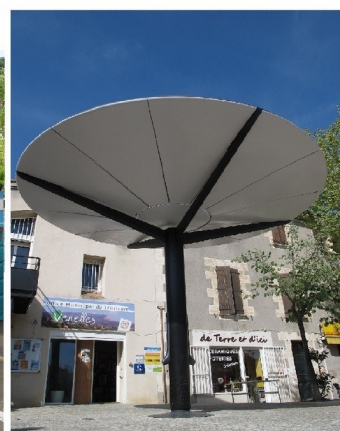
Structure métallique d'ombrière photovoltaïque
